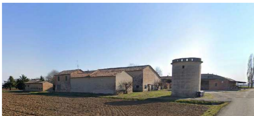
Figure 4 e 5: Cascina a corte aperta sviluppata su tre lati, C. S. Bernardino Sopra, Fiorenzuola d'Arda - Google Earth
