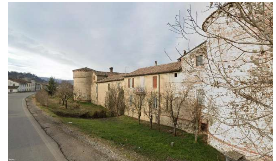
Figure 11 e 12: Castello di Folignano lungo la SP 36, Pontedell'Olio – Google Earth
