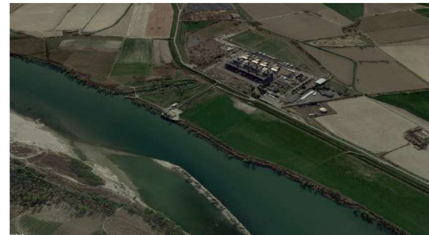
Figura 8: Centrale termoelettrica La Casella – Google Earth
