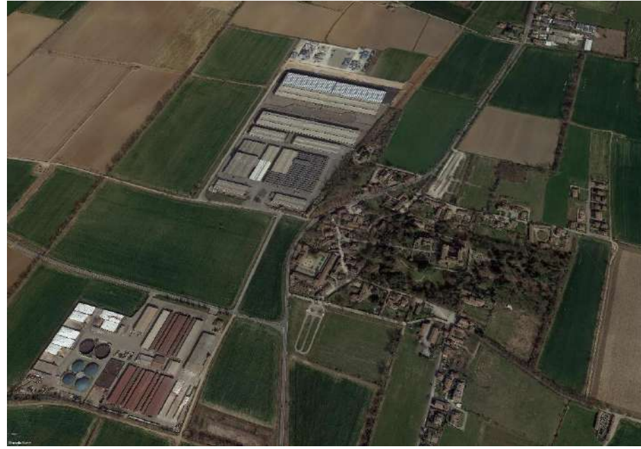
Figura 7: Il borgo di Grazzano Visconti e la zona industriale di Vigolzone – Google Earth
