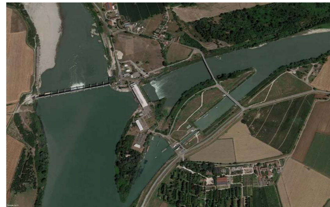
Figura 4: Sbarramento idroelettrico di isola Serafini, nel comune di Monticelli d'Ongina – Google Earth
